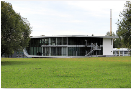
Uniteil 3: Erfenschlager Str.
