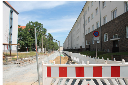
Baustelle No. 659 (Chemnitz)
