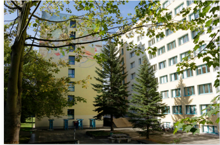
Das Wohnheim an der Vetterstraße 66
