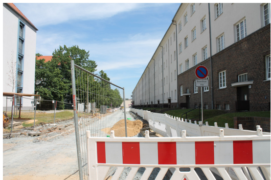
Baustelle No. 659 (Chemnitz)
