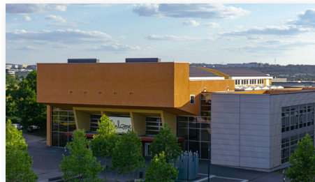
Unitteil 2: NHG Reichenhainer Str.
